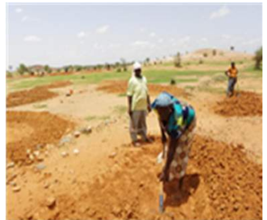
Un site de travaux CFW
